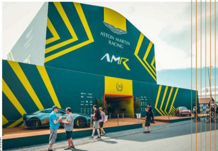
Structure réceptive éphémère réalisée par la société iEvent sur les 24 Heures du Mans.
